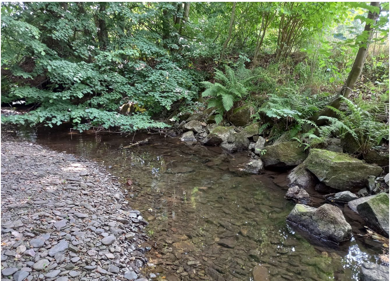
Foto 7 a 8: Pomístní stabilizace břehů kamenným záhozem. Michal Gerža, 12. 4. a 28. 7. 2022.
