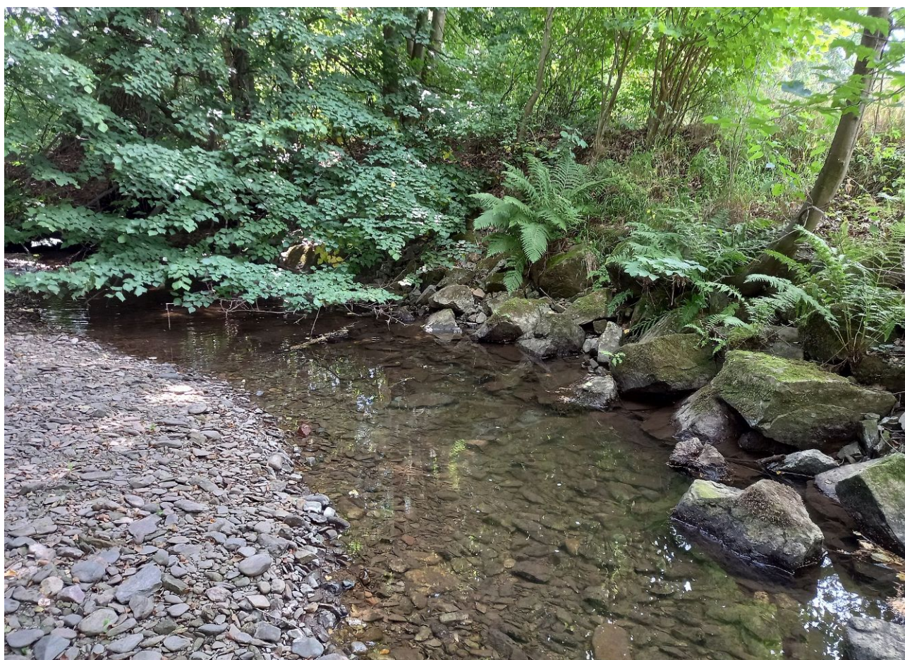
Foto 7 a 8: Pomístní stabilizace břehů kamenným záhozem. Michal Gerža, 12. 4. a 28. 7. 2022.
