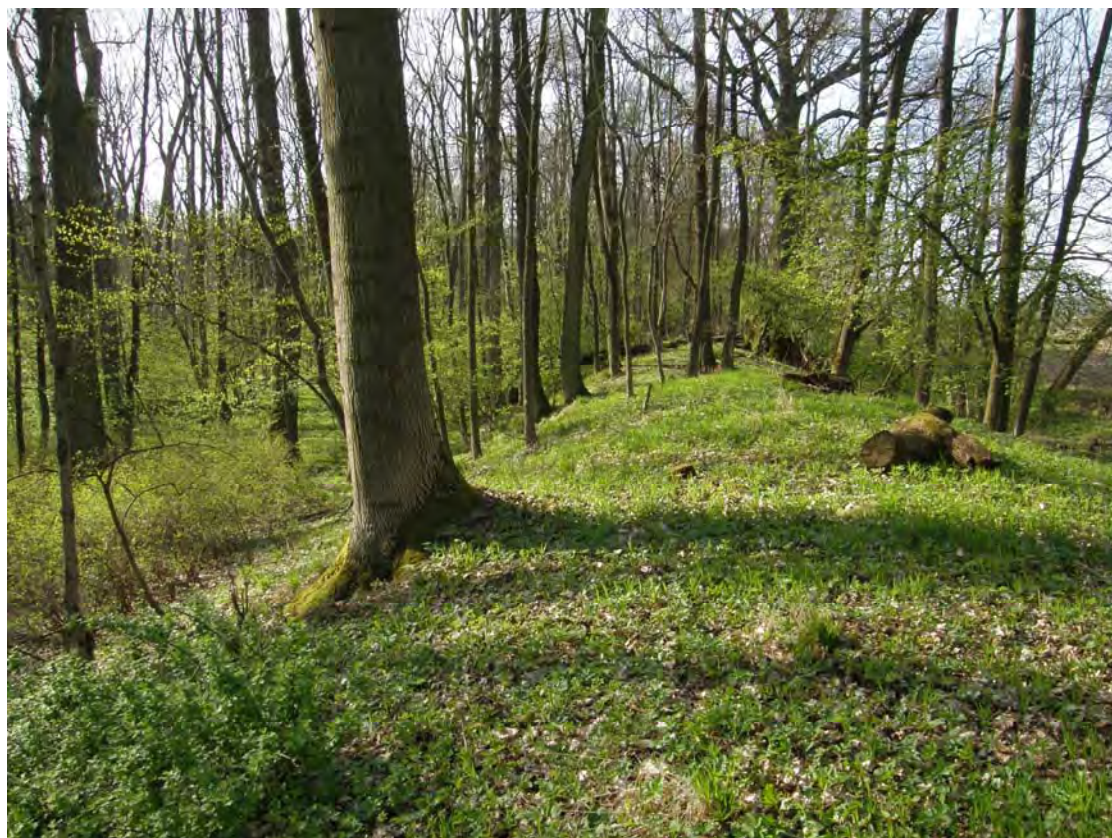
Hráz na SV okraji - por. 706B17/8
