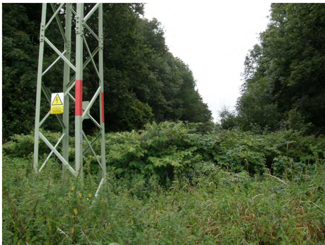
Invazní křídlatka pod elektrovodem v S části
