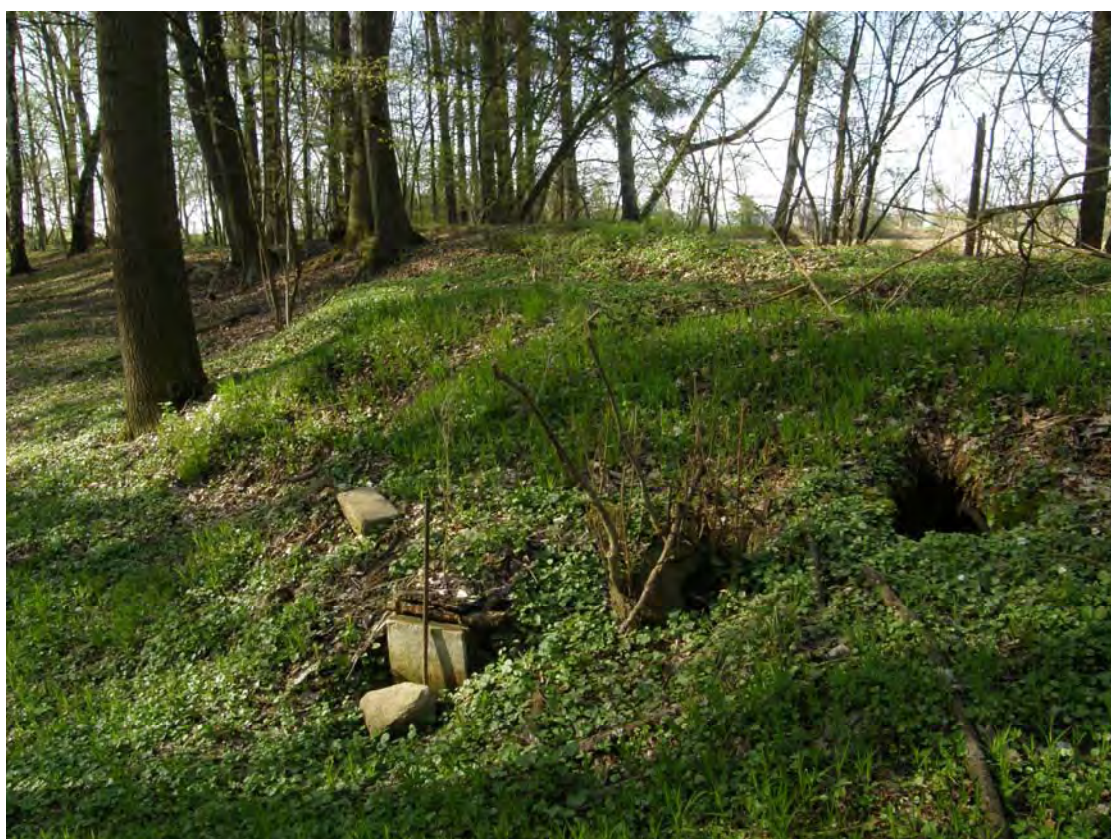
Hráz na SV okraji - por. 706B17/8
